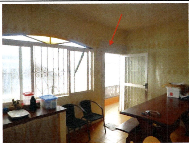
Foto 26 – Destacamento de azulejos na cozinha
