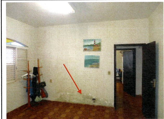
Foto 27 – Manchas de umidade no quarto que faz divisa com o banheiro social
