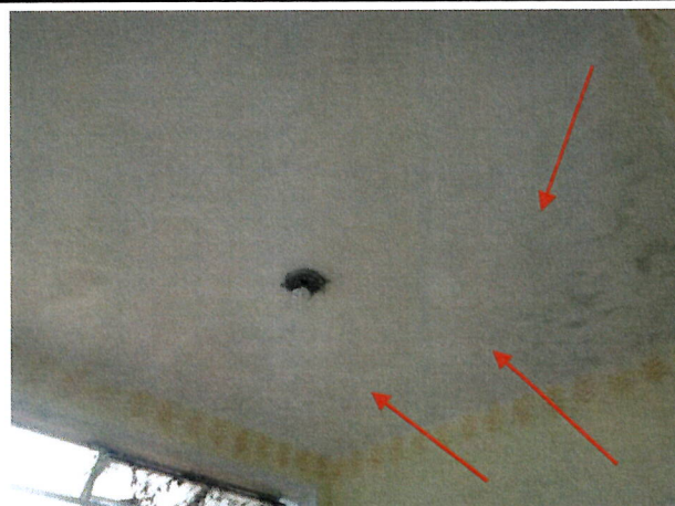
Fotos 31 e 32 – Manchas de umidade nos tetos da lavanderia e do banheiro da empregada
