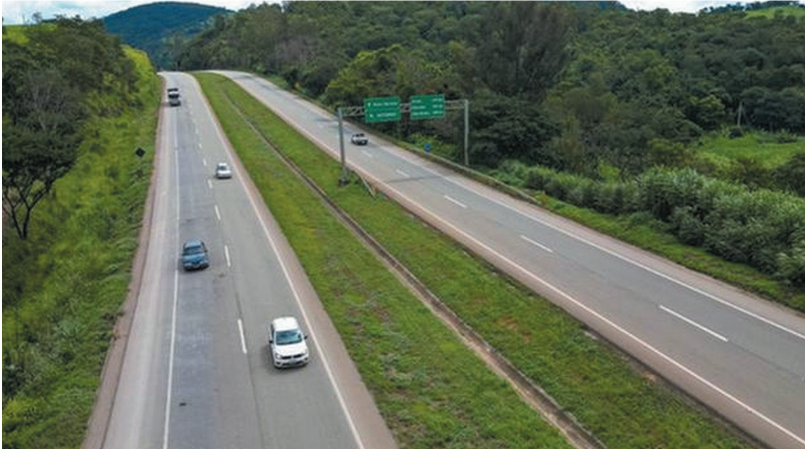
Do montante anunciado de investimento da concessionária, R$ 4,4 bilhões serão destinados a obras e serviços de infraestrutura
